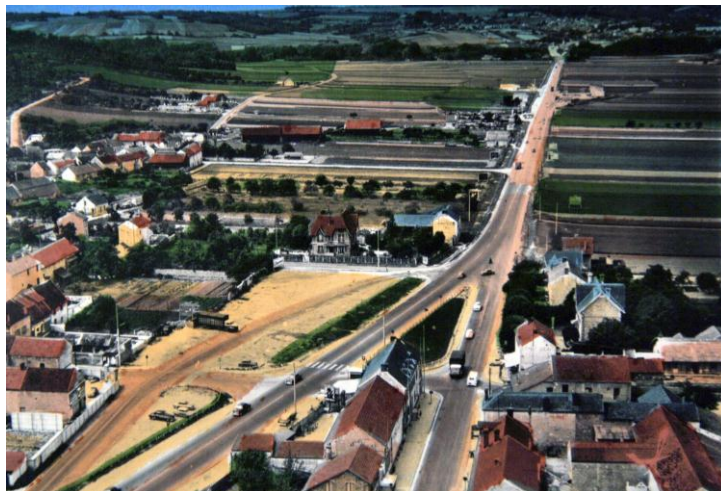
(Travaux d'élargissement de la RN13 au début des années 60 – carte collection J.C. Bigant)
