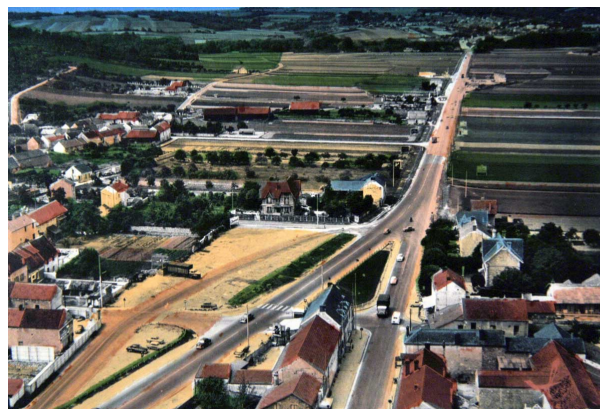
aménagement de la chaussée au milieu des années 1950
